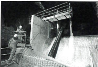
Au bout de la passerelle, la prise d'eau est constituée d'un barrage de 4 mètres de haut.
