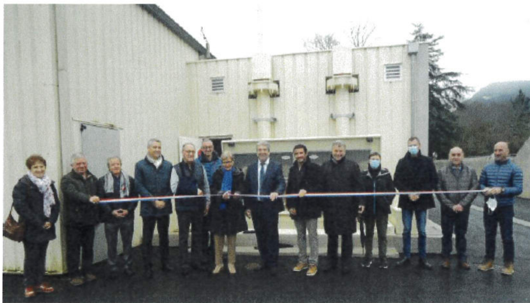
Entourée par l'ensemble des partenaires, la sénatrice Denise Saint-Pé a coupé le cordon symbolique devant la chaufferie.
